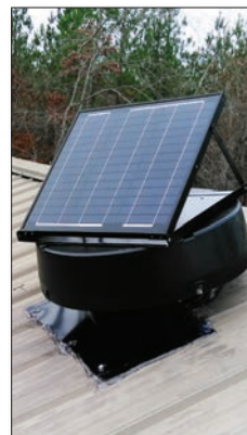
Solar Attic Fan
